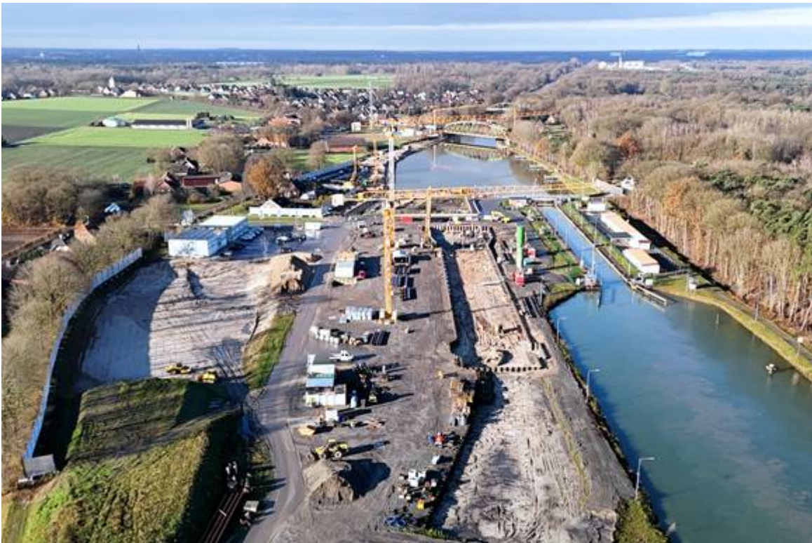
Foto : Baustelle Schleuse Rodde am 29. November 2024
