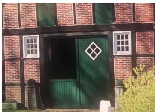
**Abb. 25 Zur Belichtung wurden kleine Fenster im oberen Teil der Flügel eingebaut**
