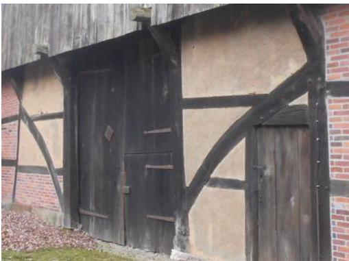
**Abb. 8 Hinter dem Lehmputz könnten sich noch Staken und Flechtwerk befinden**
