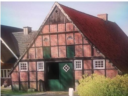
**Abb. 10 Fensteröffnungen im Raster der Fachwerk-konstruktion**
