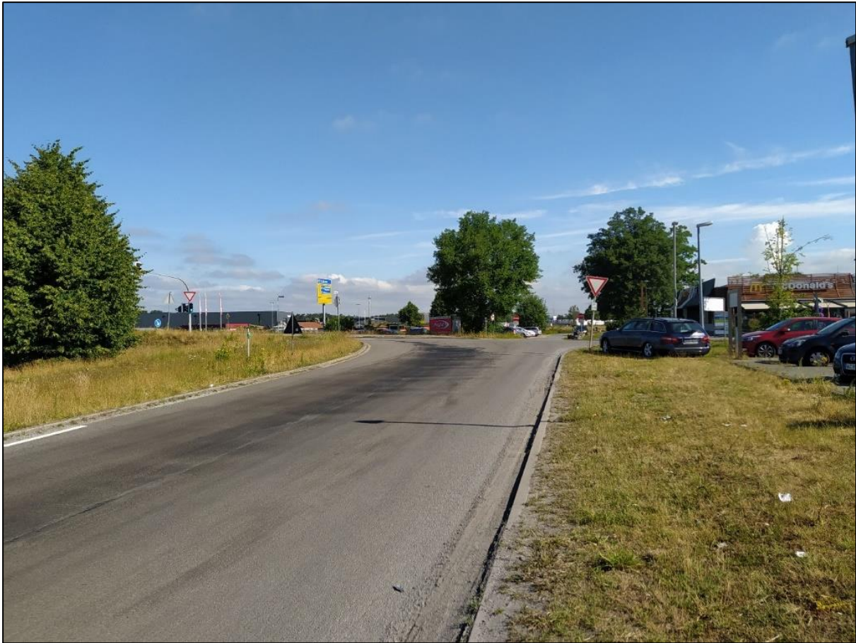
Abbildung 8: Einmündung Paxtonstr. / Mendelstr. – Blickrichtung Nord (Quelle: Aufnahme IPW)
