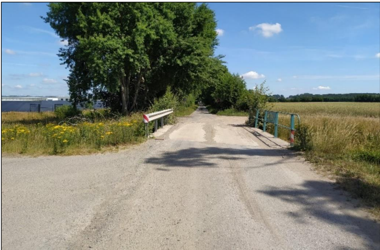
Abbildung 14: Brückenbauwerk über den Ahlder Bach (Quelle: Aufnahme IPW)
