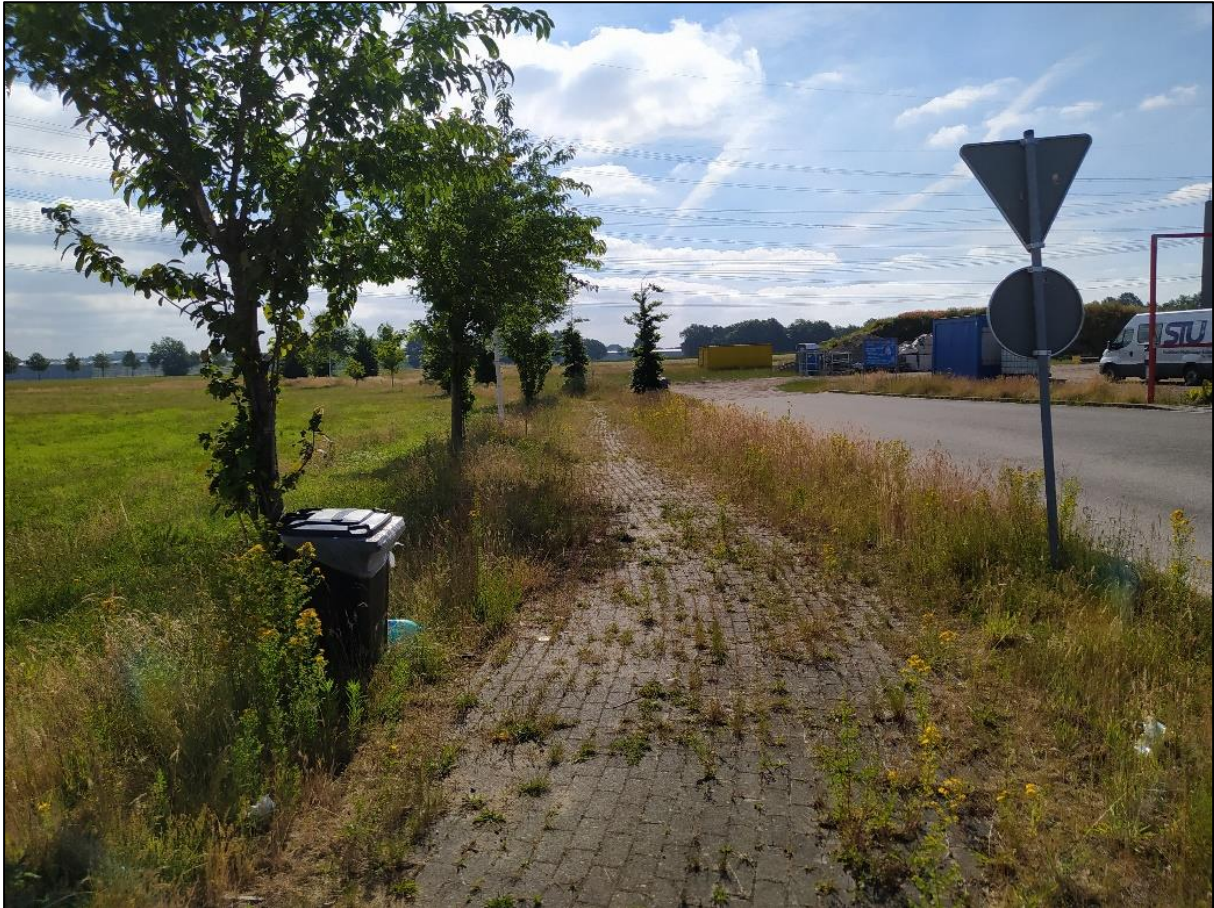
Abbildung 5: Bauende Paxtonstr. östlich des Kreisverkehrs Merianstr. – Blickrichtung Ost (Quelle: Aufnahme IPW)
