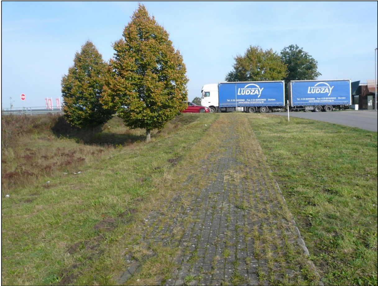
Abbildung 6: Gemeinsamer Geh- und Radweg Mendelstr. - Blickrichtung: Paxtonstr. (Quelle: Eigene Aufnahme)
